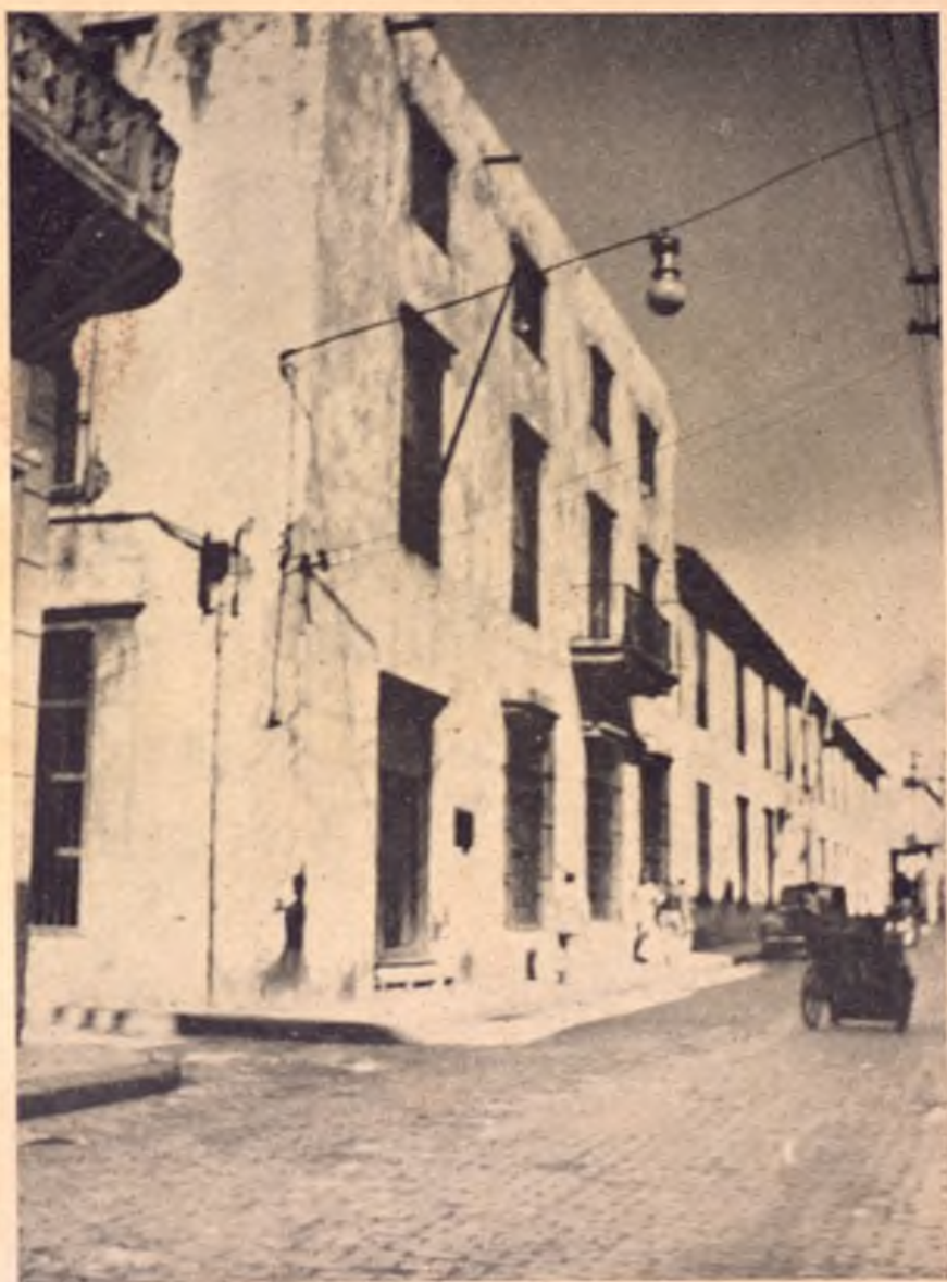
Exterior del viejo edificio del Archivo Nacional.
