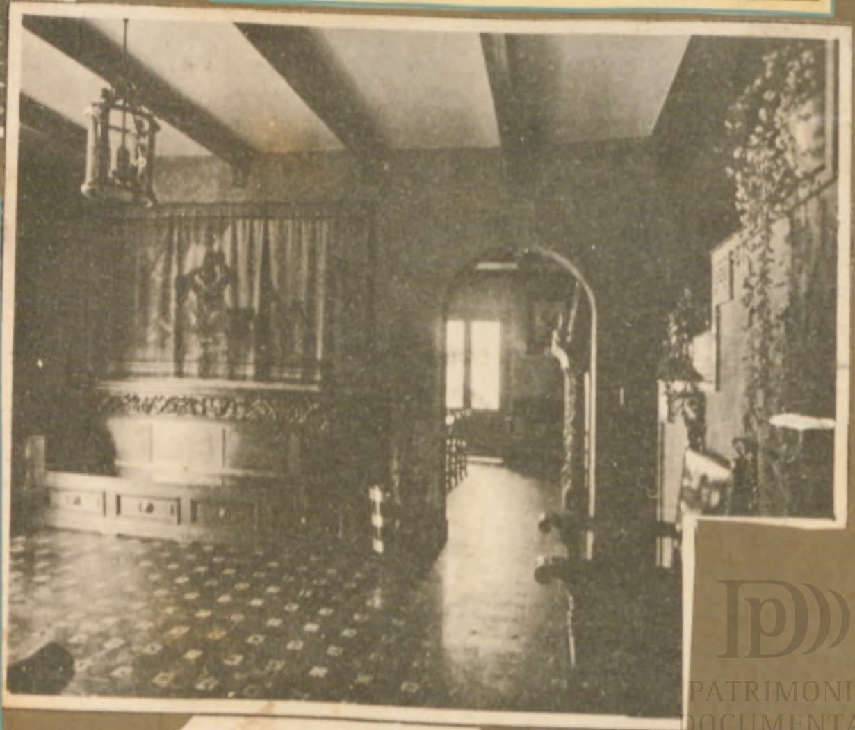
Un aspecto del hall y escalera.
