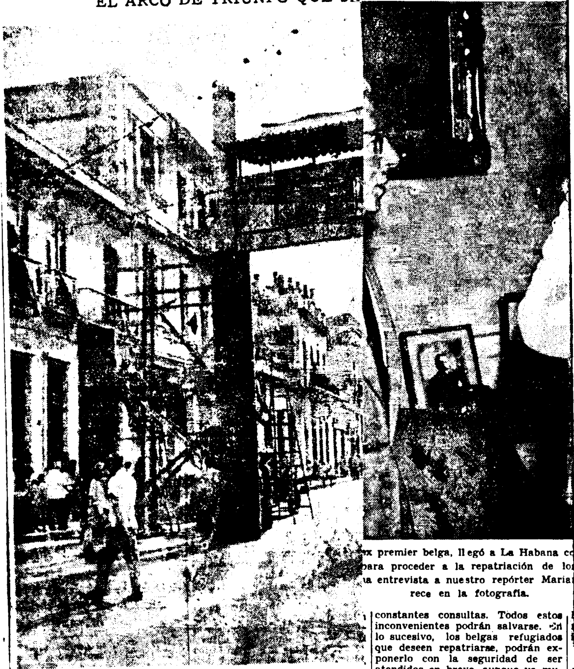
Ayer por la tarde varios obreros concluan la instalación del Ar... la esquina de las calles Zanja y Campanario. Allí terminará el
