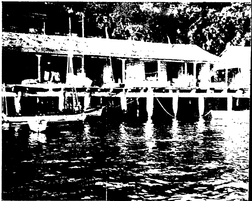
Casas montadas en pilotes.
