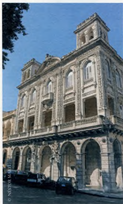
Fachada del inmueble sito en Prado No. 302 esquina a Ánimas, cuyo proyecto se debió al arquitecto Luis Dedió.
