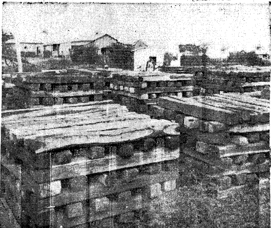
Estas traviesas para usar en las vías férreas, dan claramente una idea de cómo se hace la tala de árboles en las provincias de Oriente y Camagüey. De ahí que al no haber repoblación, las grandes masas boscosas del suelo patrio, tiendan a extinguirse.
