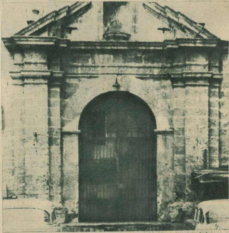
...cuerpo de arquitectura de la puerta lateral que daba a la nave de la iglesia del convento de San Francisco, con hornacina superior vacía y un rico despliegue de cantería como marco.
