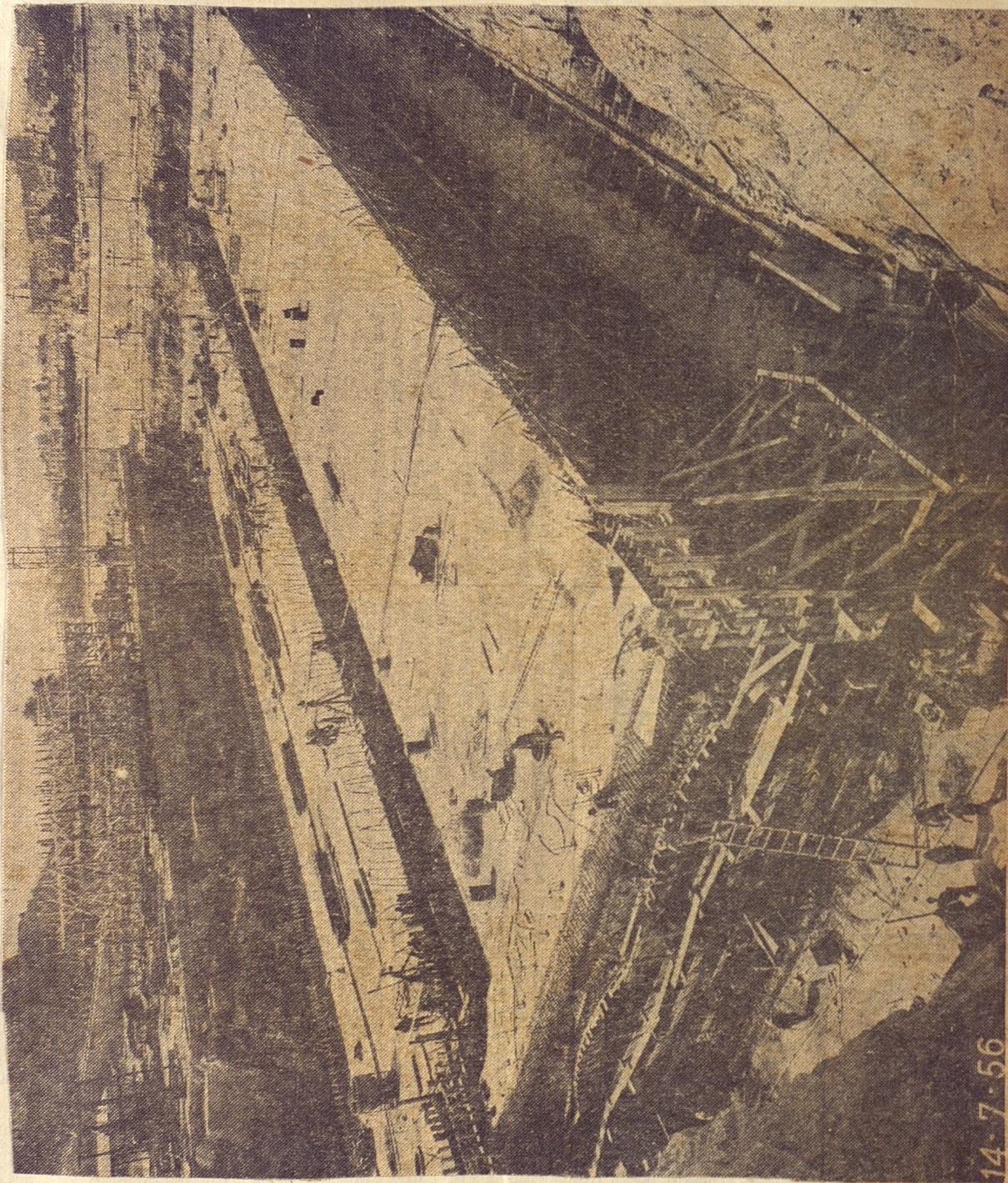
LAS SECCIONES 1 y 2 DEL TUNEL de La Habana, cuando terminada su estructura de hormigón presforzado, y retiradas las maderas del encofrado quedaron listas para las pruebas de inmersión y resistencia.
