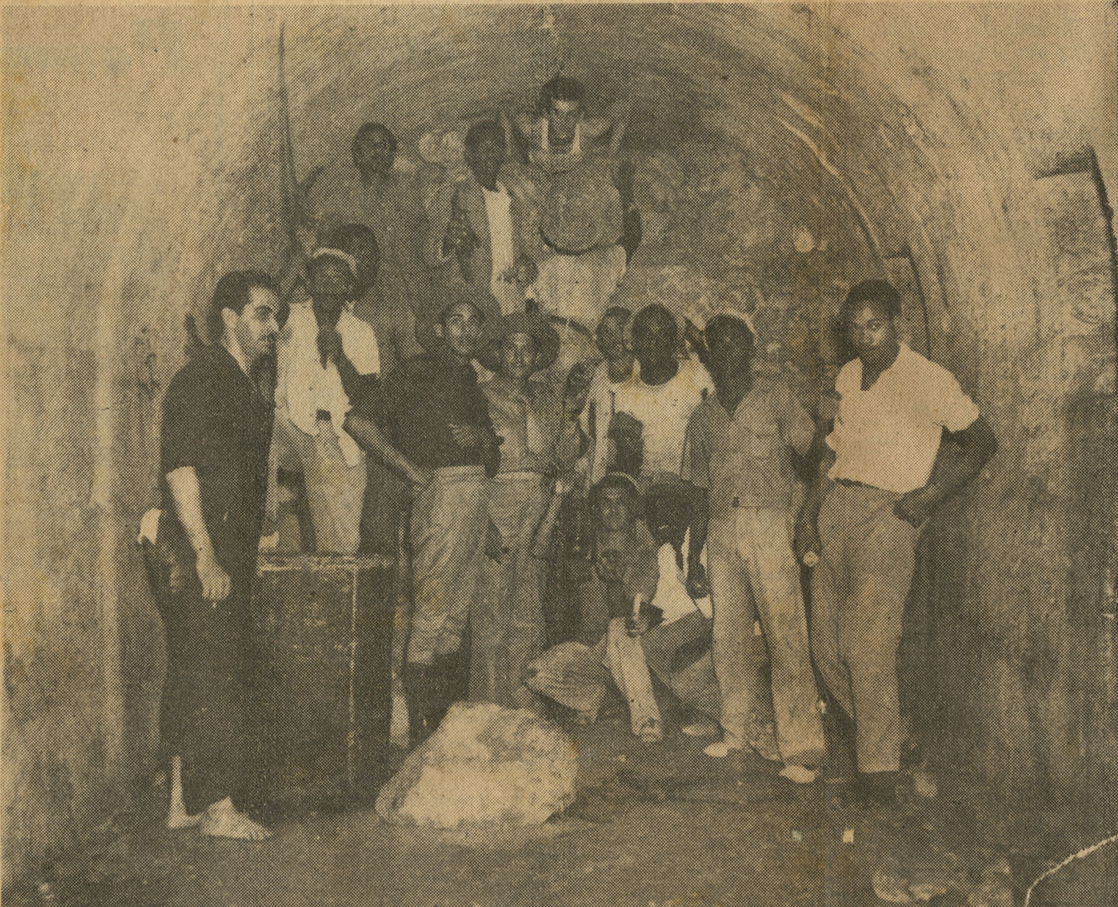
Dos soldados y un grupo numeroso de trabajadores del edificio en c onstrucción para el Dispensario y el Hospital del Instituto del Cáncer, junto al paredón que impide continuar recorriendo la gran galería circular. Tras de este muro de piedra, por cuya parte superior asoma medio cuerpo e. joven Rolando Núñez, se encuentran los que han de nominado la biblioteca, debido a la gran cantidad de libros que allí han encontrado.
