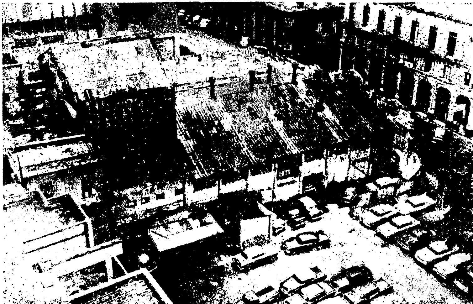
VISTA DEL parqueo de automóviles instalado en Animas y Prado, que dentro de poco tiempo se extenderá hacia la esquina de Zulueta, después de ser demolido el edificio del Teatro Principal de la Comedia sepultando entre sus escombros todo el pasado artístico que entre sus paredes encierra tan venerado templo de Talía.
