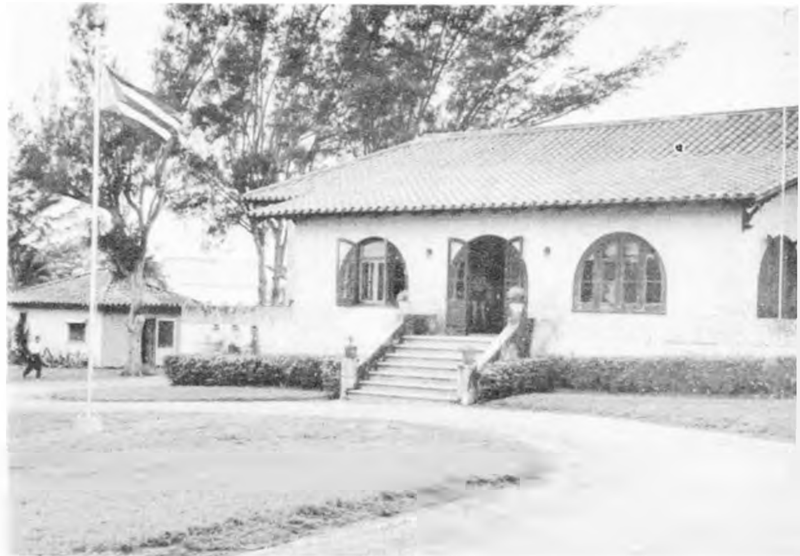
Exterior de la magnífica residencia en la henequenera "La Conchita" donde funciona la escuela "Ciro Redondo".
