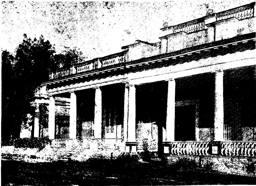
La casa de la izquierda es la marcada con el número 611 de la Calzada del Cerro, demolida para construir allí un edificio para Estación de Policía. Esta casa ofrecía la particularidad de tener la puerta principal de entrada demasiado estrecha en relación con su altura y con el ancho de las ventanas. La residencia contigua es la marcada con el número 613, conocida por "la casa de las culebras", por la mala composición que tienen los cuellos de cisnes que forman los balaústres del portal. Dos construcciones típicamente coloniales, una demolida y la otra, la 613, desnaturalizada por uno de los intrusos de la profesión para instalar allí una industria.
