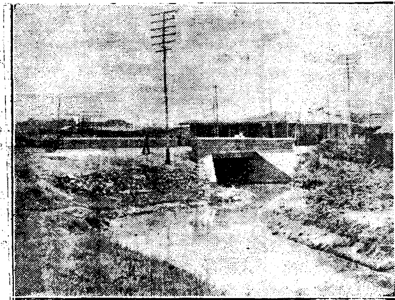
Puente de Concha sobre el llamado Arroyo de Agua Dulce. Demolido por razones de mejor tránsito, ya hoy no existe.
