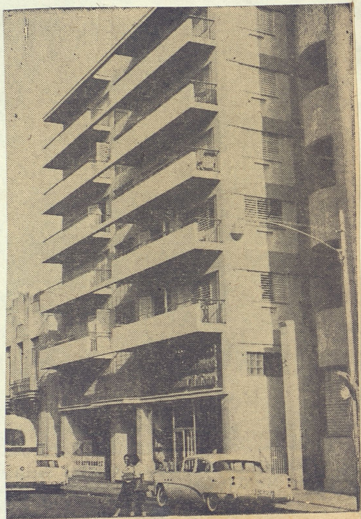
EN SAN LAZARO entre Soledad y Oquendo se fabricó este edificio de seis pisos por el arquitecto Lino Hernández Pérez, teniendo 40 viviendas. Tiene un área de 3,318 metros y su costo aproximado es de $200,00.00.
