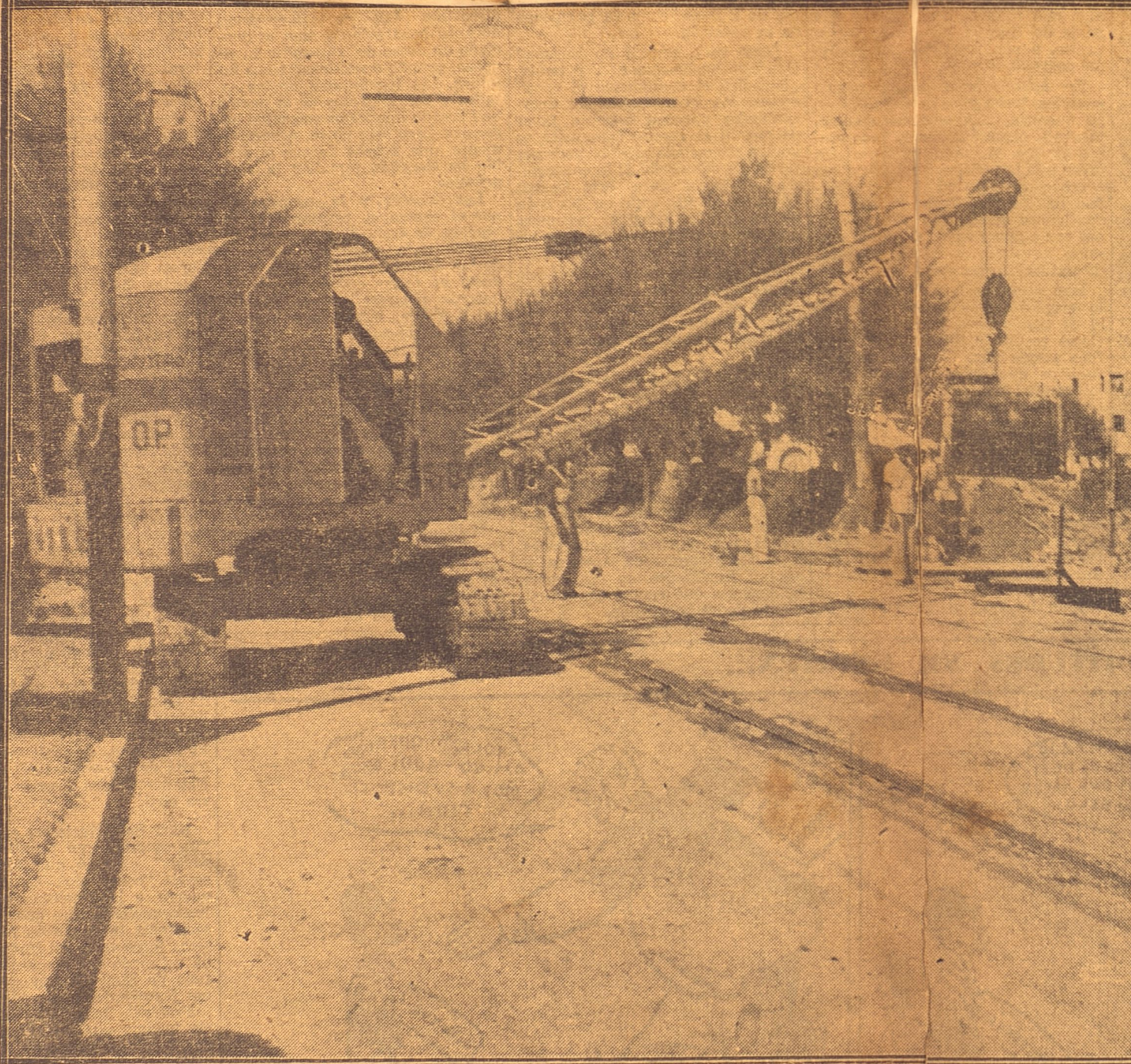
Un interesante aspecto, en la foto de la izquierda, de las obras que se realizan en el reparto Miramar. Puede verse la grúa colocando un tramo de tubo en la zanja abierta en la Tercera Avenida. En la foto de la derecha, puede observarse lo que ya, por suerte, no contempla la población habanera: el foco de inmundicias situado en la Zanja Real a su paso por frente al Castillo del Príncipe. Esta es una de las miles de obras en ejecución en toda la República, siguiendo el plan del Jefe del Estado, doctor Ramón Grau San Martín.
