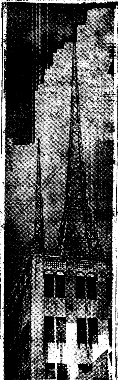
Vista de las torres de las emisoras de los Omnibus Aliados como quedaron después del terrible huracán que asoló a La Habana. Como puede observarse quedaron intactas dichas torres.
