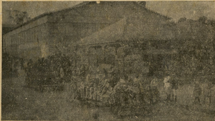
En la fotografía de unos carnavales banenses, se observa el antiguo edificio del teatro "Heredia", con sus dos kioscos al frente. En uno de éstos estaba el famoso café "La Cubanita".
