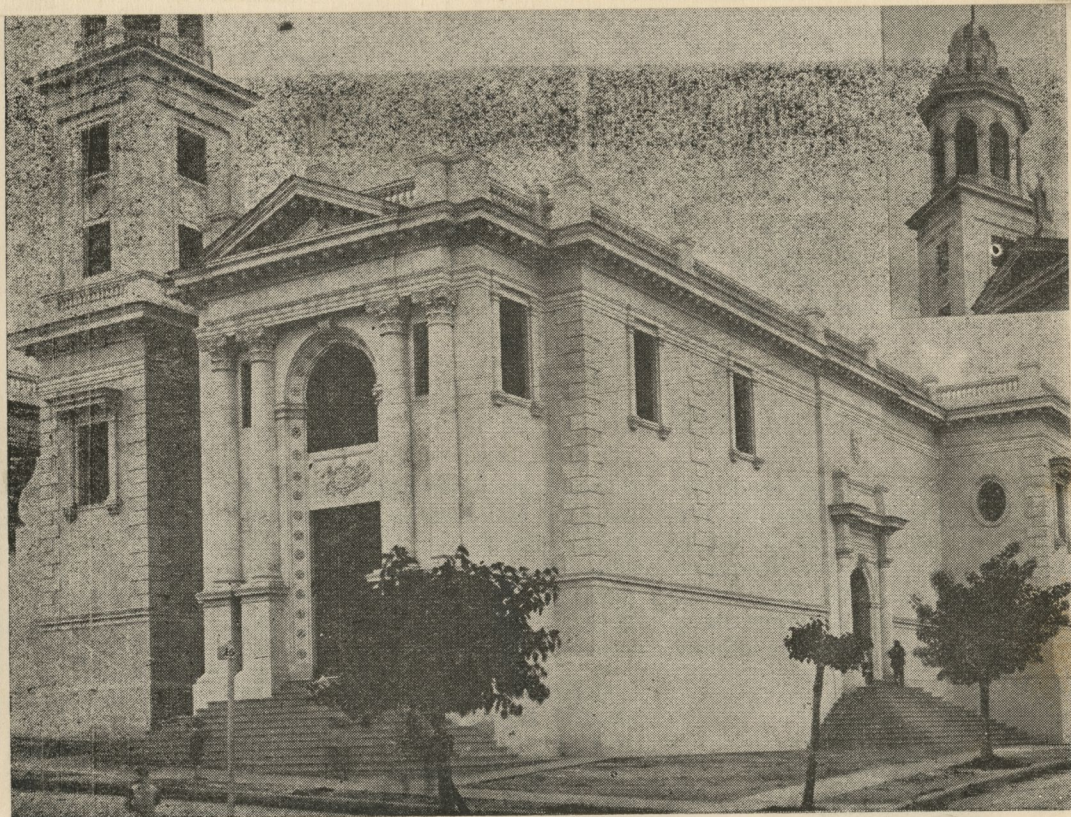
Capilla del Monasterio de Santa Clara de Asís, Luyanó. Vista general de las fachadas de sillería y detalle de los cuerpos superiores del campanario. 1927.
