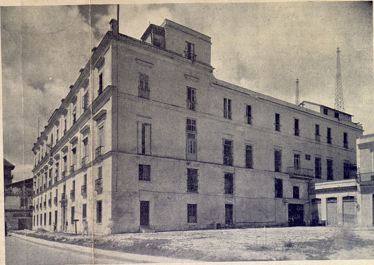
Vista del frente y uno de los costados del edificio de la Secretaría de Agricultura, antes de la restauración de sus fachadas.
