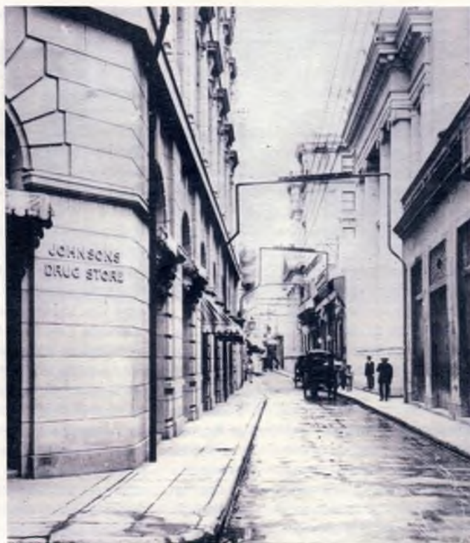
Desde 1914 la Droguería Johnson ocupa el edificio con esquina en Obispo y Aguiar. En 2000 fue restaurada íntegramente para convertirla en farmacia de la comunidad.
