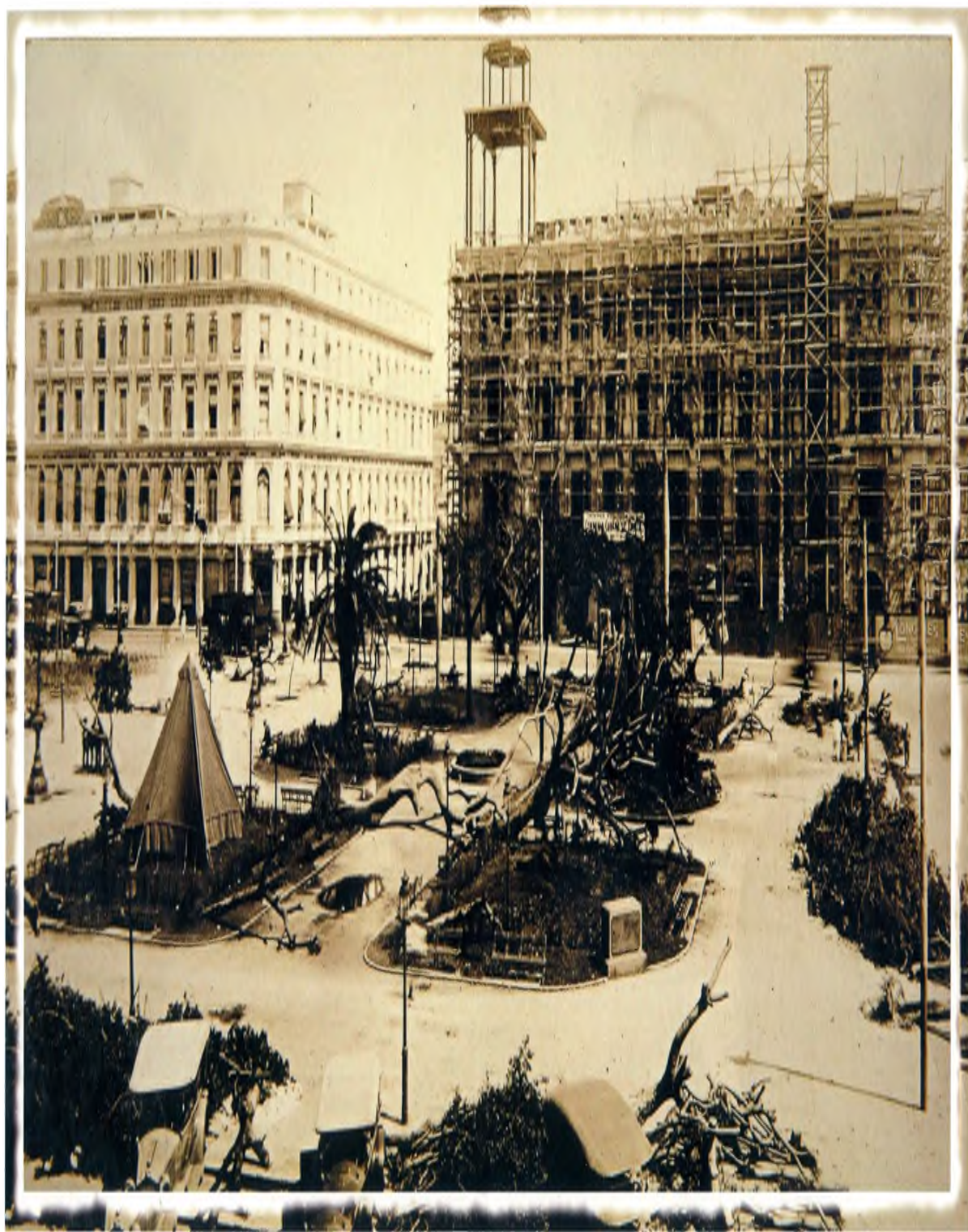
A pesar de su furia, el ciclón de 1926 no dañó las potentes estructuras de acero del Centro Asturiano en construcción.
