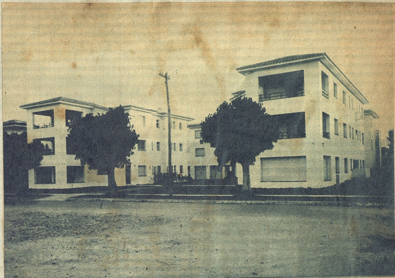
El arquitecto FERNANDO R. DE CASTRO ha hecho maravillas en estos dos solares de 6, entre 3a. y 5a., en Miramar. Cuatro bellos edificios de apartamentos, bien aireados e independientes, construyó para su propietaria la señora L. Sánchez de Latour .
