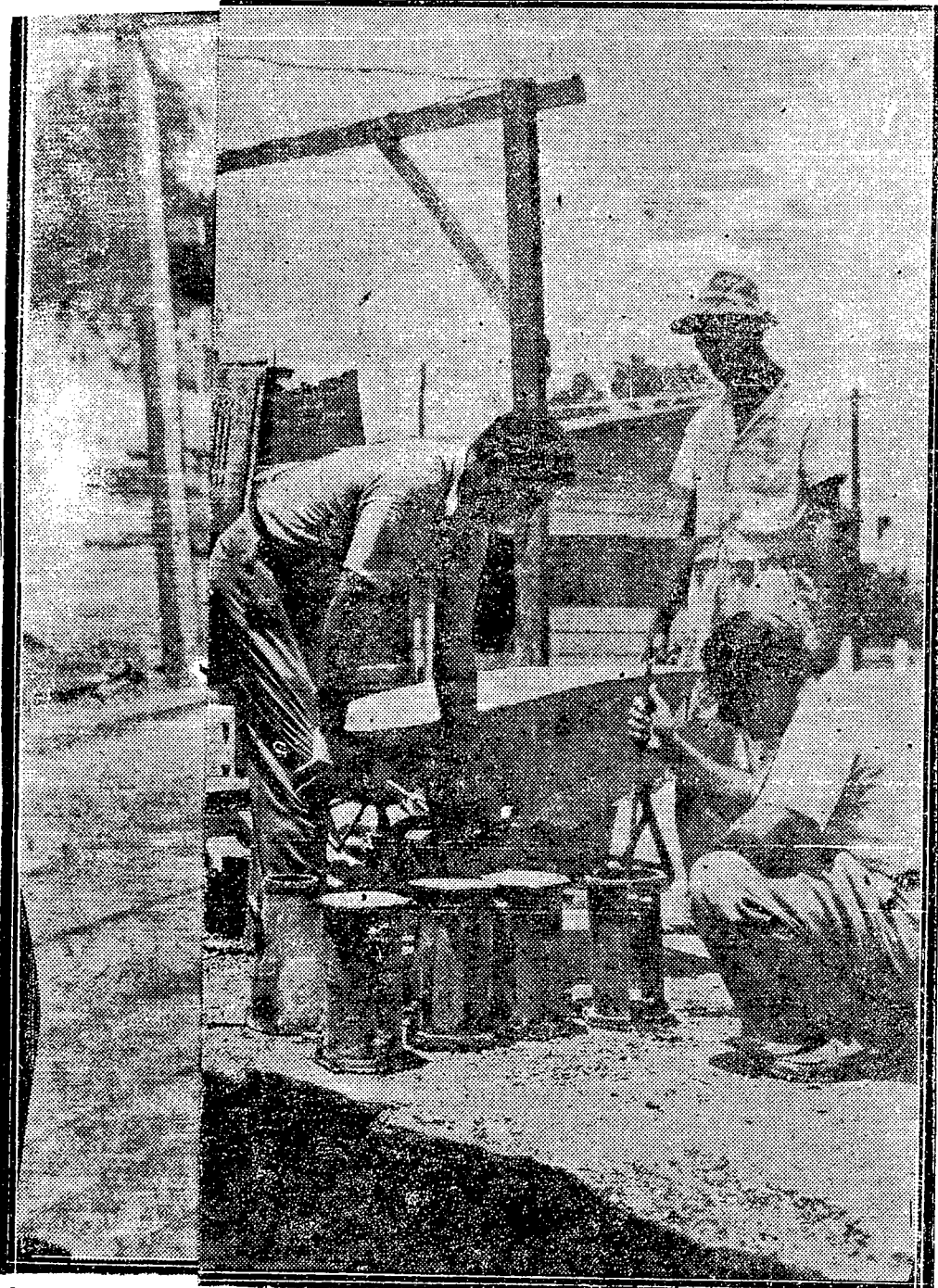
En la presente compones foto de la izquierda nos darse cuenta a los milena- teria, en la foto de la derecha vemos a dos empleados del Ministerio tomando muestras de hormigón con cesino a la u-beria del alcantarillado.
