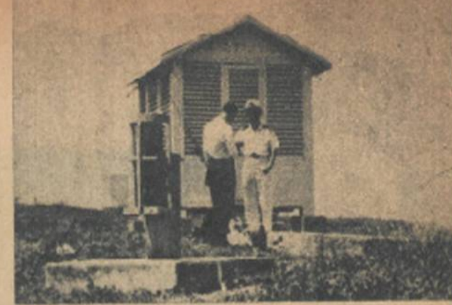
Caseta meteorológica, donde están instalados los elementos medidores de temperatura y humedad. A la izquierda el Pluviómetro.
