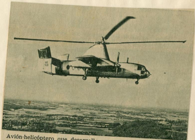
Avión-helicóptero que desarrolla una velocidad de 185 millas por hora, despega verticalmente para tomar después las características de un avión de dos motores. Construido en Inglaterra.
