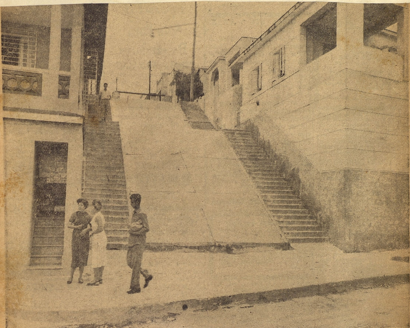
Córdoba entre Morúa Delgado y Font es un caso de calle pavimentada, pero no transitable por vehículos de ninguna clase, no sólo por su gran pendiente sino también por el plano horizontal que presenta en su centro.
