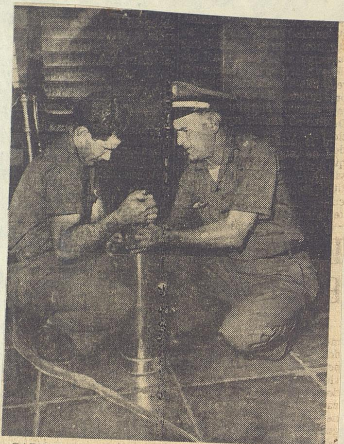
CARGANDO LOS EXTINGUIDORES de mano el producto llamado Foamite, que se convierte en espuma y hace posible la desaparición del fuego en la gasolina, vemos en esta fotografía a un oficial y a un bombero.
