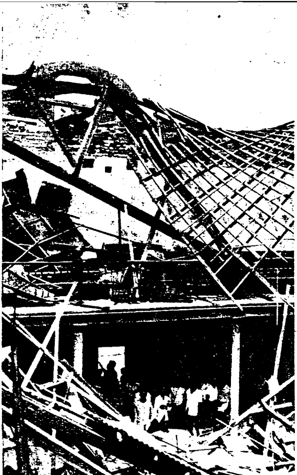
Del único teatro que había en Bolondrón no han quedado más que paredes derruidas, montones de maderas destrozadas y ruina para sus modestos propietarios...
