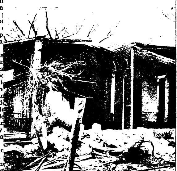
Destrozos causados por el huracán en el pueblo de Bolondrón.
