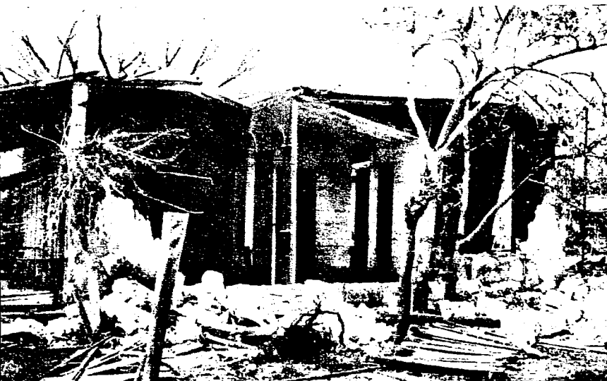
Destrozos causados por el huracán en el pueblo de Bolondrón.
