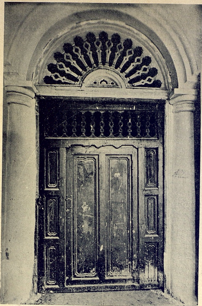
P UERTA de tableros moldurados y medio punto calado, en el desembarque de la escalera junto a la Galería Superior. Palacio de los Marqueses de Arcos. Siglo XVIII.
