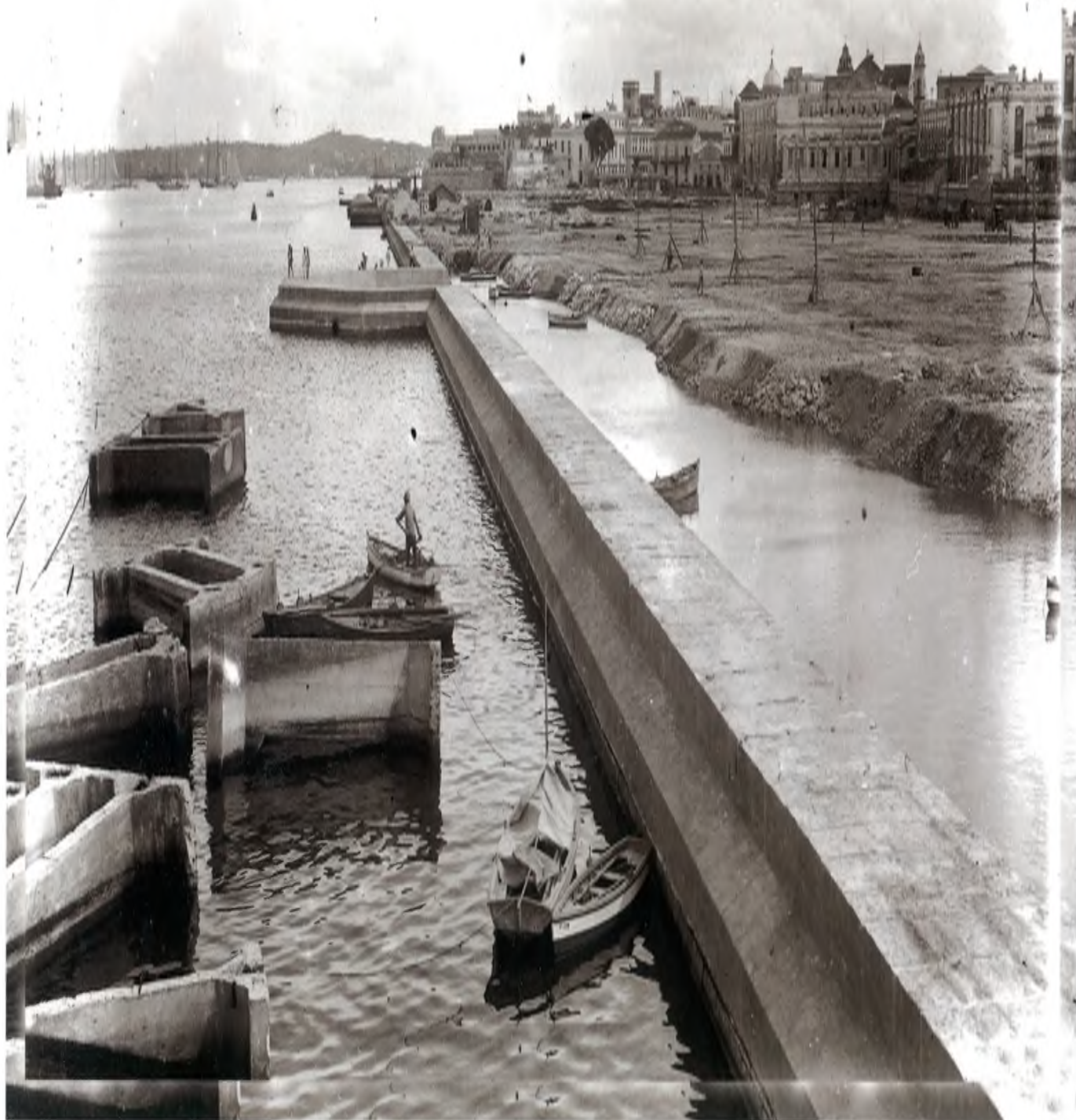
Construcción del nuevo malecón en la entrada al puerto habanero, cuando ya se había colocado el último bloque de hormigón (noviembre de 1928). Al fondo todavía pueden verse los restos de la muralla marítima, incluida la garita y baluarte de San Telmo.
