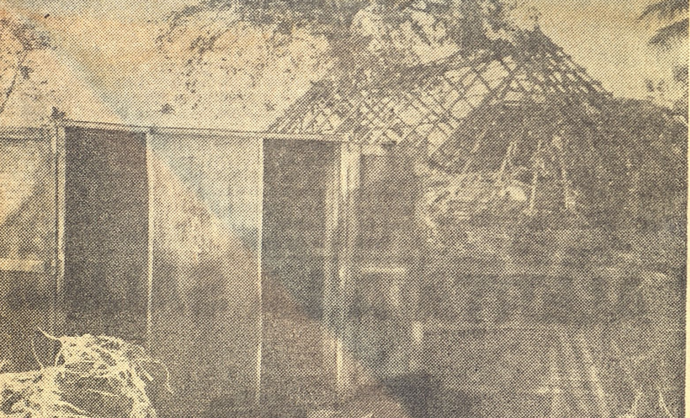
De la casa quedó sólo el escaparate vacío. Al fondo, el techo dismantelado. La foto es del poblado de Guayitos, uno de los lugares más cruelmente afectados de toda la provincia oriental.
