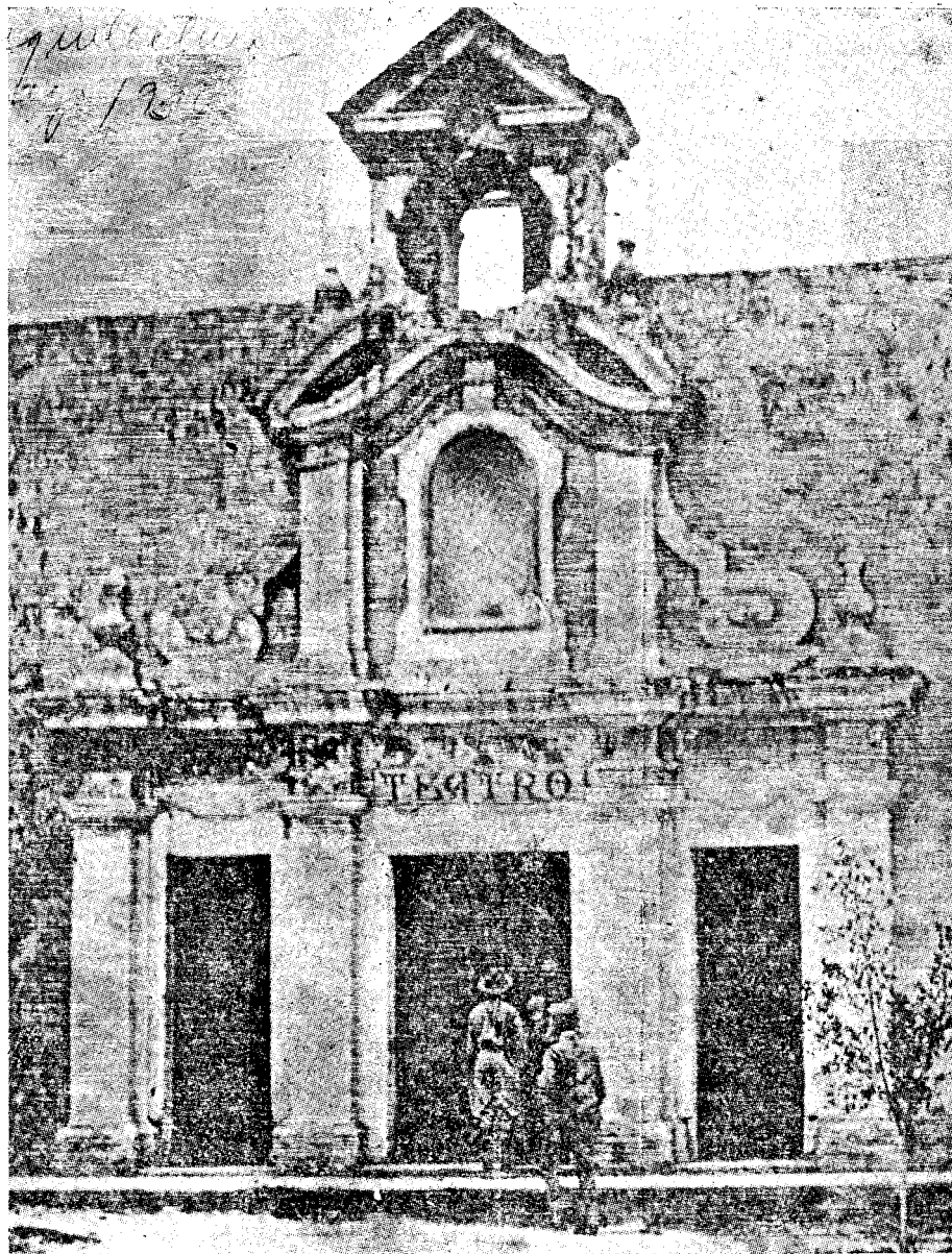
Fortaleza de la Cabaña. Fachada de la antigua Capilla, dedicada después a Teatro y posteriormente Sala de Consejos del Tribunal Militar. Pedro Medina y Silvestre Abarca, Arquitectos.
