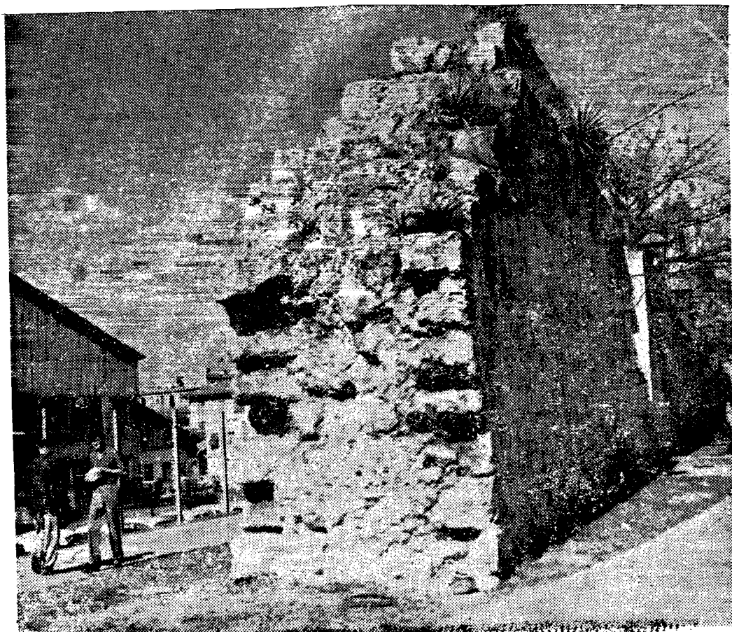
EN 1880 SE COMENZO la demolición de esta antigua muralla
