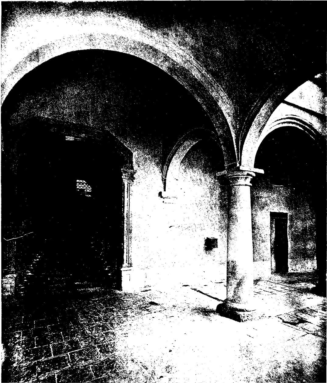
A NGULO de la Galería de la Planta Baja, frente al arranque de la Escalera. Palacio de los Marqueses de Arcos. Siglo XVIII.
