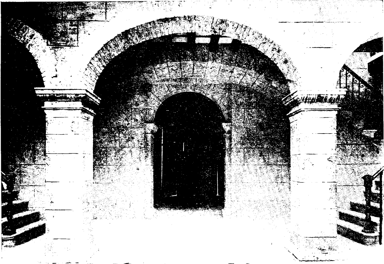
CASA DEL CONDE DE CASA BAYONA. GALERIA DE LA PLANTA BAJA. ESCALERAS.
