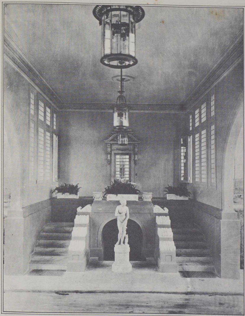
Detalle de la misma por dentro.
