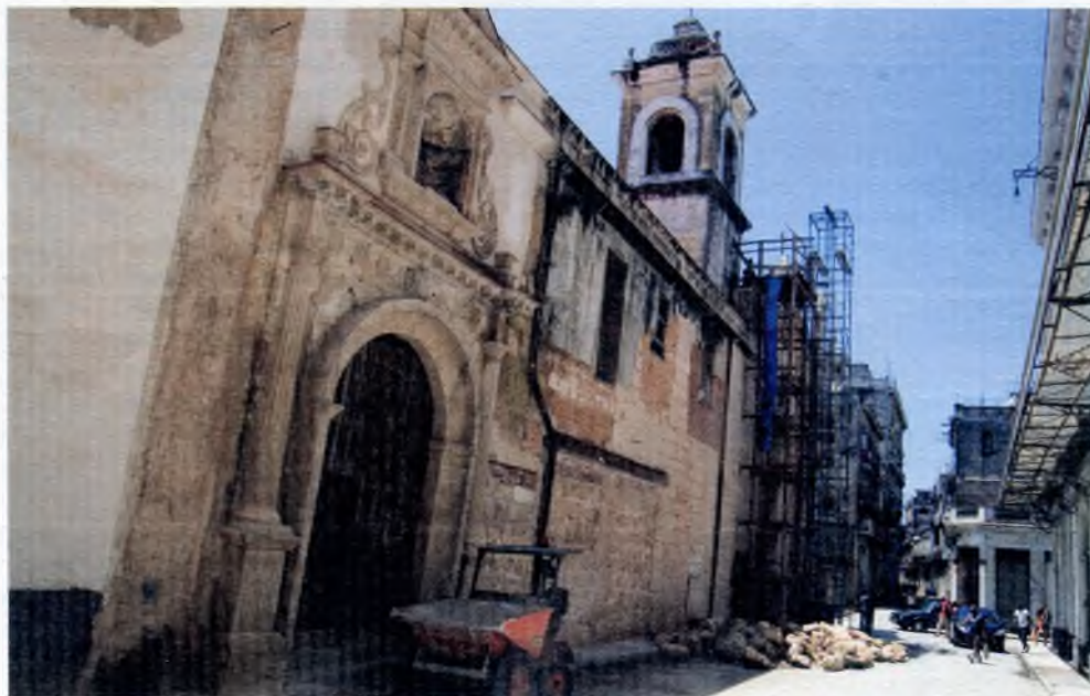
Vista actual de la fachada del antiguo convento de Santa Teresa de Jesús, por la calle Compostela.
