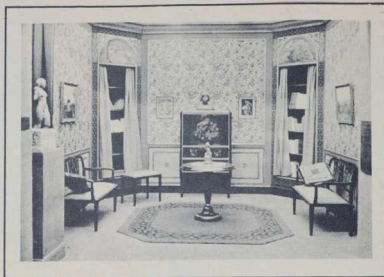
Instalación de la casa Antonio Badrinas. Plafones y telas estampadas de José Obiol.
