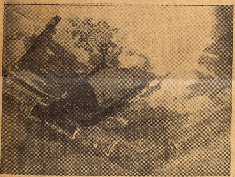
El techo de la sala de la casa de Perseverancia 66, altos, que fué atravesado por uno de los maderos que salieron disparados del edificio en construcción en Perseverancia y Lagunas.
