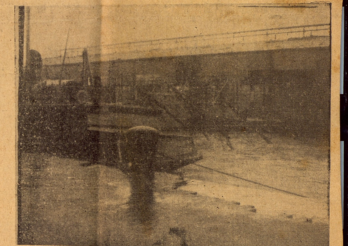
Sólo tres mástiles, que sobresalen sobre las aguas ya tranquilas de la bahía, revelan el sitio donde se hallaba anclada, junto al espigón de Paula, la goleta Bacardi II. Idéntica suerte corrió una nave igual a ésta. Advirtiéndose también los daños en los muelles.
