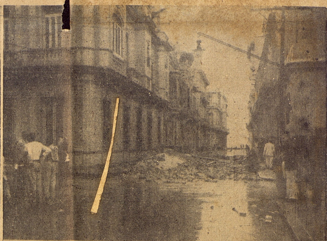
La Casa del Artista, en Lagunas y Perseverancia, sufrió grandes desperfectos. El último piso se derrumbó causando los escombros en su caída graves daños a las casas colindantes.
