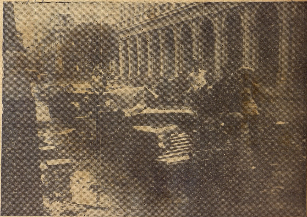
Sobre dos bellos autos, parqueados en Trocadero en tre Prado y Zulueta, cayeron los escombros de un balcón y una cornisa arrancados por el huracán, hundiéndoles totalmente el capó.
