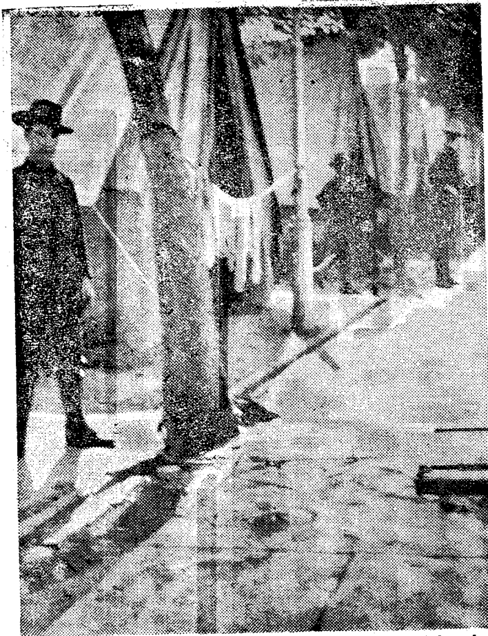
Debido a las condiciones poco higiénicas de los cuarteles de La Habana, las tropas de los Estados Unidos pusieron sus campamentos en los parques. La fotografía muestra una sección de la policía militar norteamericana, acampada en Prado y San José. En esta situación estuvieron hasta que se fundó el Cuerpo de Policía en la Capital.
