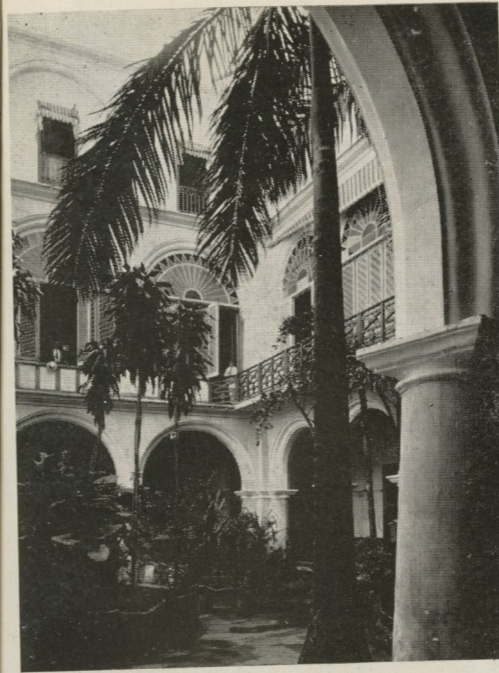
Patio del Convento de San Francisco
