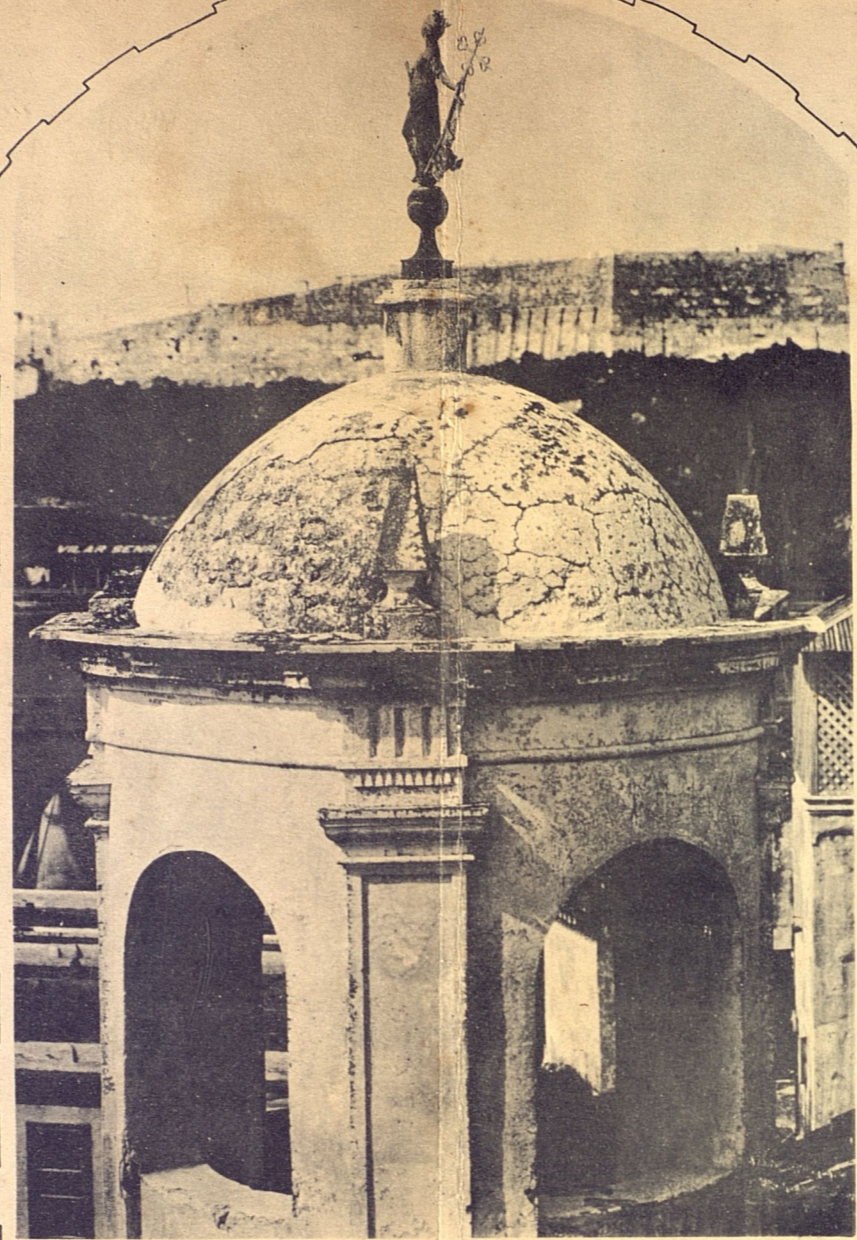
El torreón y campanario del Castillo de la Fuerza, coronado por la estatua en bronce de La Habana, que el ciclón arrancó y echó a tierra. Al fondo se ve la fortaleza de la Cabaña.
