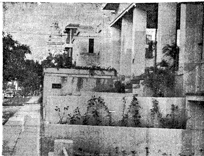
En el Vedado, barrio residencial que otrora producía admiración a los extranjeros, se están cometiendo también múltiples agresiones al urbanismo y a las Ordenanzas de Construcción. Obsérvese el contraste que ofrece el primer edificio a la derecha, cuyo arquitecto-constructor dió solución al garaje en forma de semisótano, y el edificio de la esquina con su antiestético garaje construido en el espacio que debe ocupar el jardín.
