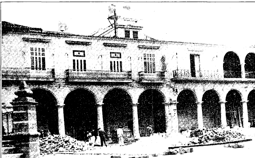
Un aspecto del costado de la casa de los Condes de Lombillo, a la izquierda, y del frente de la casa del Marqués de Arcos, a la derecha, después de descubierta la arquería del piso alto, que permaneció ignorada y oculta por el repello que encubría los paramentos de las paredes levantadas para el relleno de dichos huecos. Restauración debida al Arquitecto Luis Bay.
