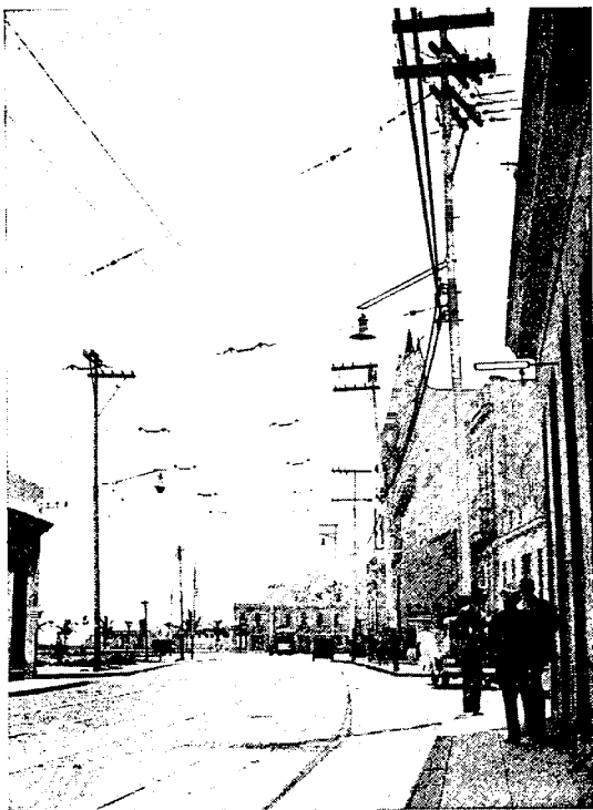
Conjunto de postes y alambres del alumbrado público y de la línea de los tranvías, en la calle de San Lázaro o Avenida de la República, a poca distancia del Parque de Maceo.
