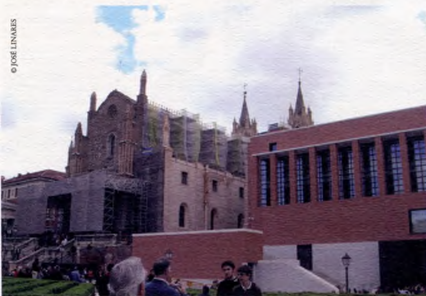
Realizada en octubre de 2007, esta foto muestra la iglesia de los Jerónimos (izquierda) y el «Cubo de Moneo», como se denomina a la edificación de ladrillos que, conteniendo los restos del segundo claustro de ese conjunto monasterial, constituye la nueva ampliación del Museo del Prado.
