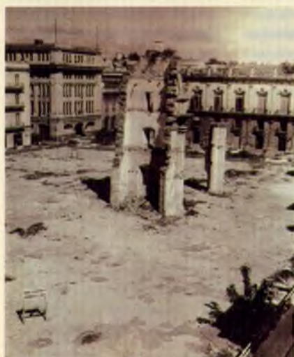
Restos del Convento de San Juan de Letrán cuando su demolición se hallaba virtualmente concluida hacia junio de 1957.
