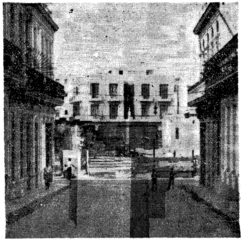
Aspecto que ofrece actualmente la prolongación de la calle Soledad, desde Animas hasta San Lázaro. Los materiales de construcción allí acumulados, precisamente donde se abrirá la calle, obstruyen totalmente el solar yermo que allí había.
