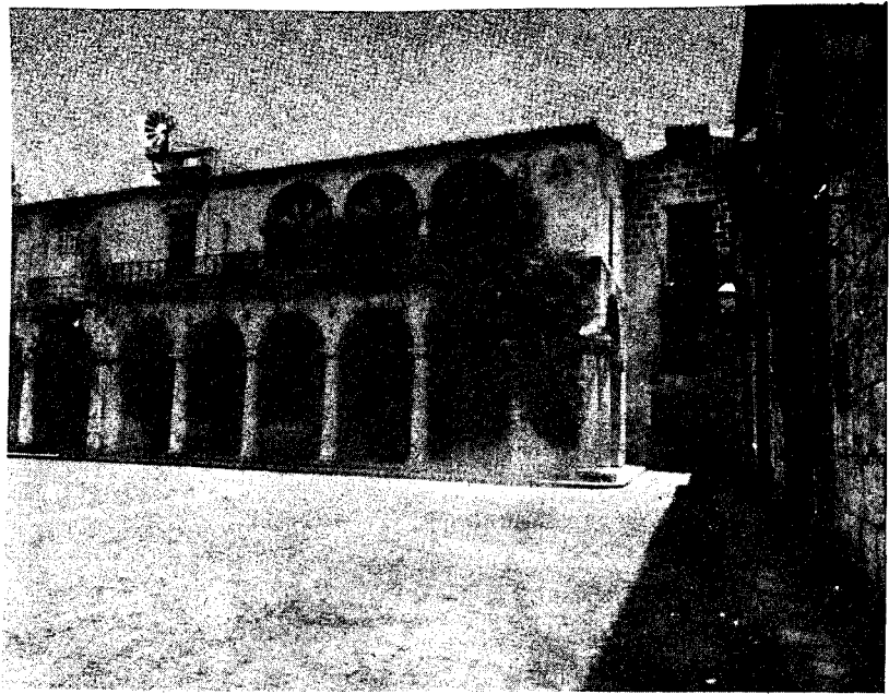
Viejo Palacio del Marqués de Arcos, que forma un ángulo recto con la fachada de la casa del Conde de Casa Bayona, a la derecha, tal como quedó su fachada después de la restauración de la plaza, hecha por la Secretaría de Obras Públicas, bajo la dirección del arquitecto Luis Bay Sevilla.
