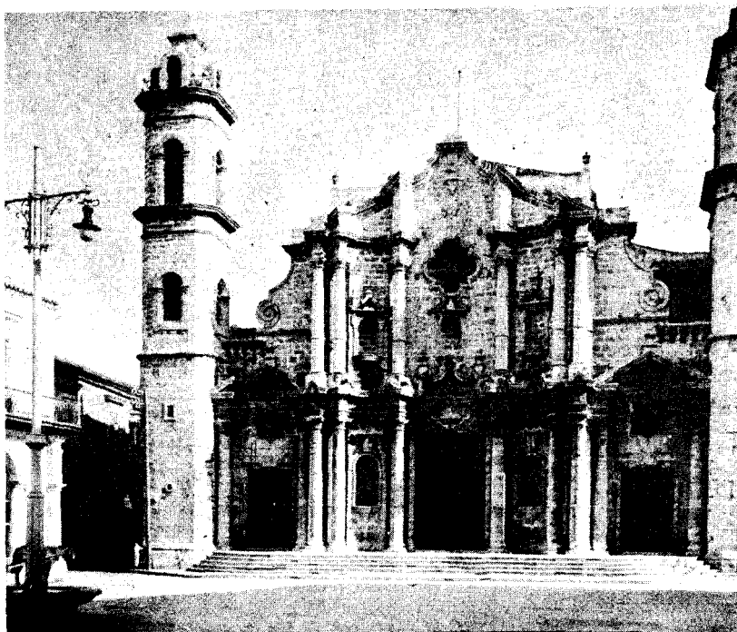
Fachada de la Catedral, en los primeros años de la República, cuando en el centro de la plaza existía un poste ornamental con dos focos eléctricos, y una fuente que servía de abrevadero a los caballos de las "guaguas" que tenían su paradero en dicho lugar, y a las demás bestias de carga que transitaban por allí.
