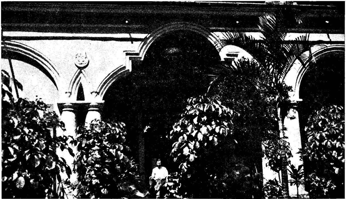
Arco central de la galería de la planta baja, formado por un medio cuadrifolio y descansando sobre columnas pareadas. Seminario de San Ambrosio.
