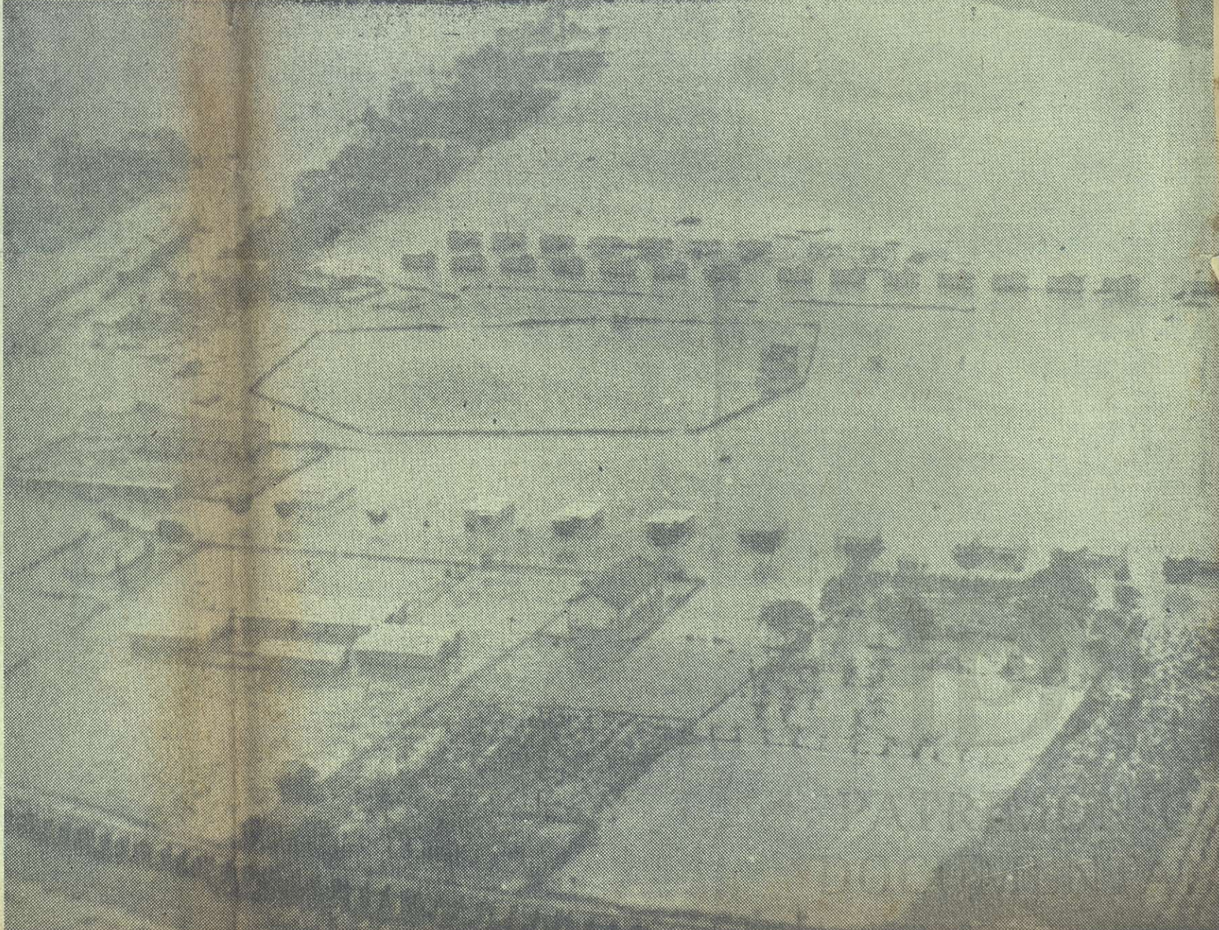
Una de las granjas próximas a Bayamo, una de las zonas orientales más afectadas por el huracán, aparece en la vista aérea rodeada por las aguas. En la foto pueden apreciarse los límites de los distintos sembrados, inundados casi por completo.
