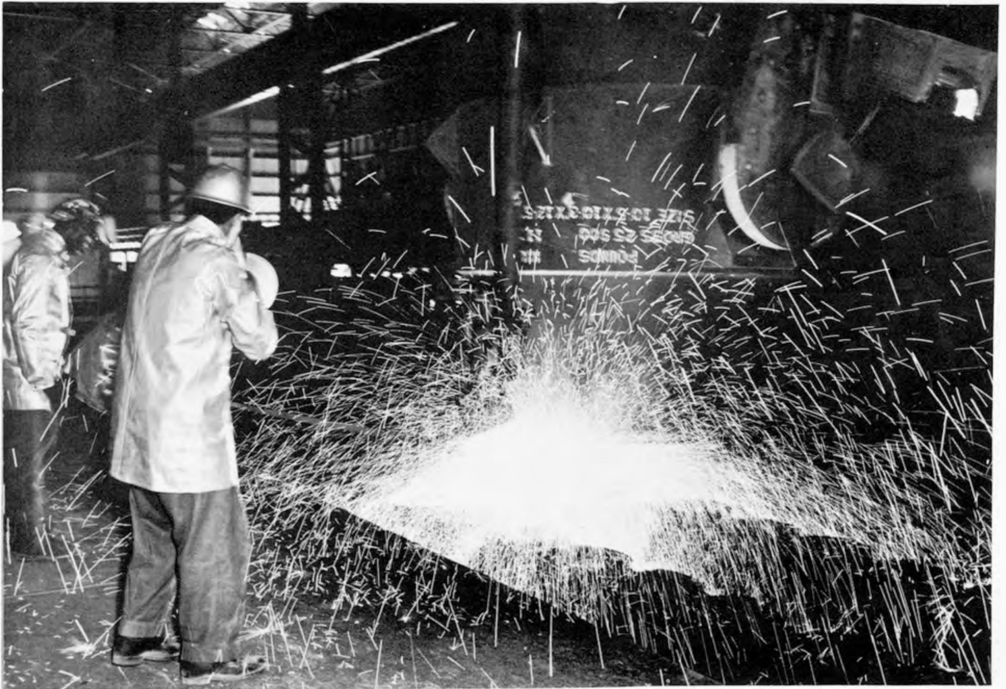
Estos técnicos observan el proceso y la grúa hace descender el cubilote sobre las dos hileras de moldes a los que va llenando lentamente. A la derecha, el campo de chatarra de la planta y la grúa que mediante un electroimán levanta con facilidad pesadas cargas de acero.
