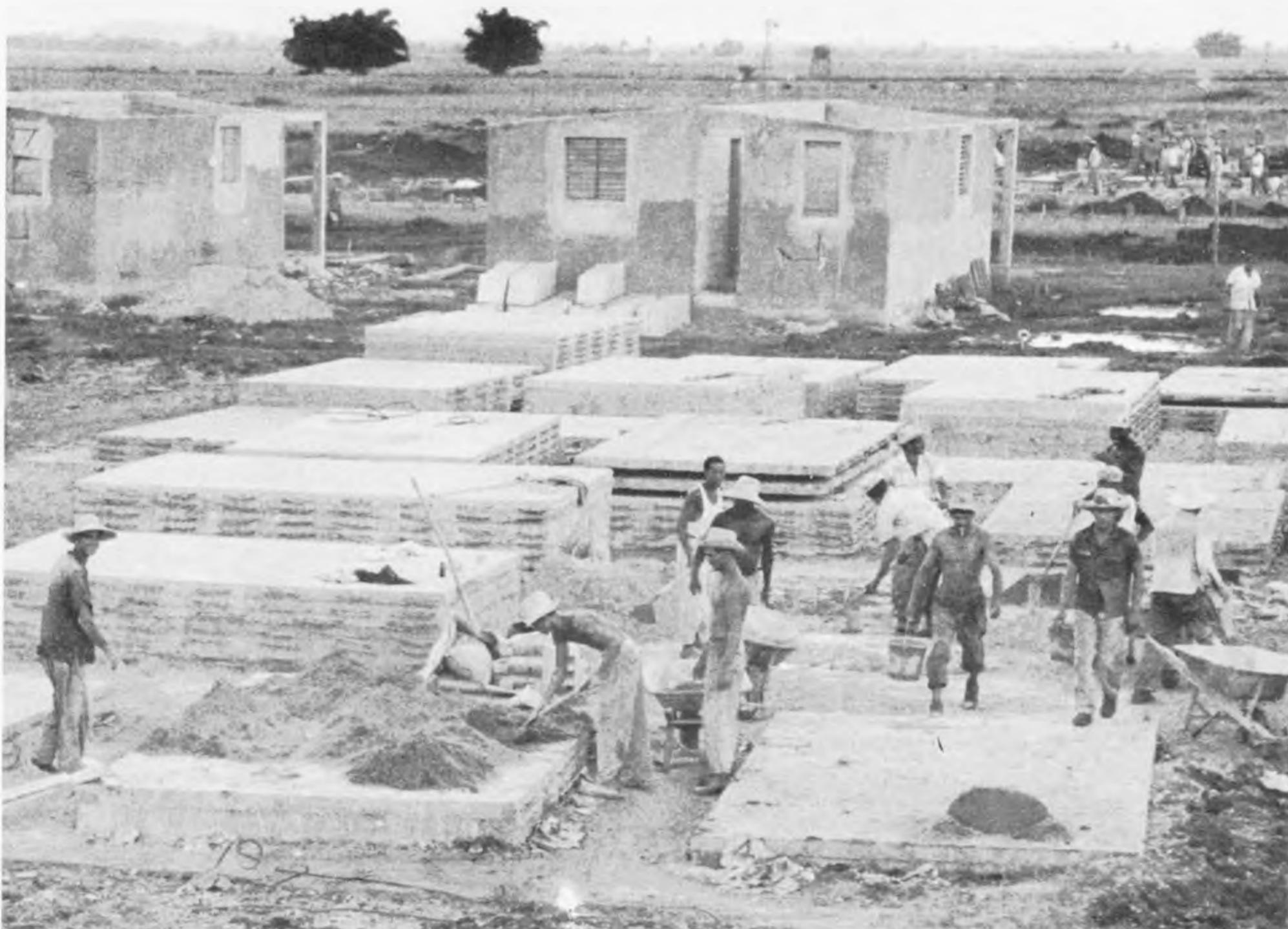
Paredes y techos de concreto se funden en serie para ser colocados rápidamente por medio de grúas poderosas.
