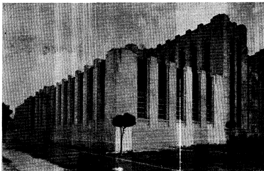
Obras de ampliación y reformas del Hospital Municipal de Maternidad "América Arias"
