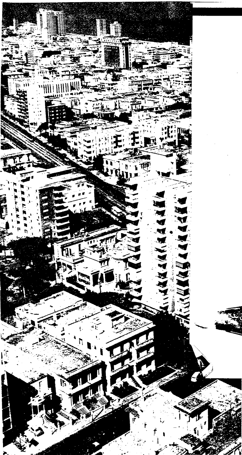
Vista parcial de La Habana moderna, tachonada de rascacielos y cruzada por avenidas multivías. En algunas de sus zonas comerciales el terreno vale tanto ya, que el espacio que ocupa un mosaico se justiprecia en cien pesos.
