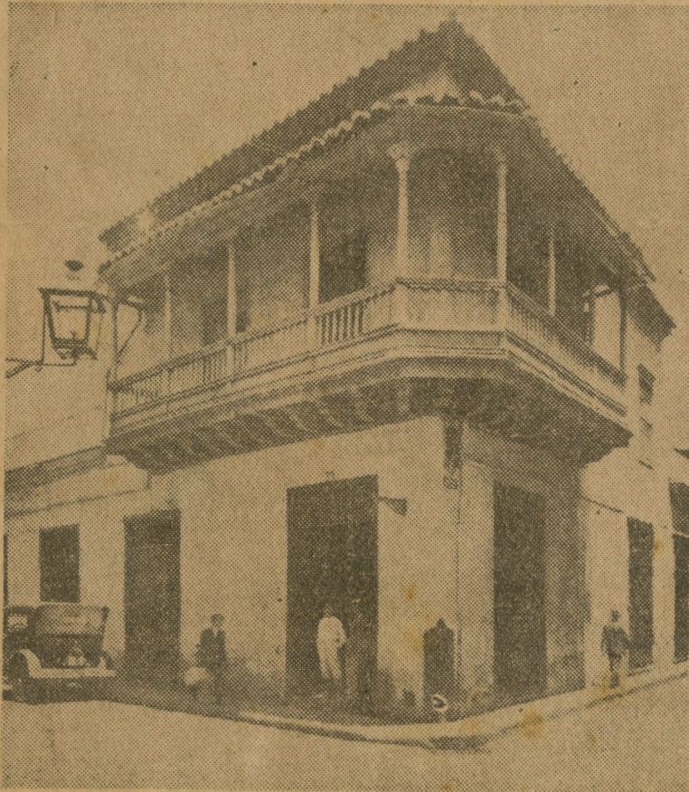
Fachada de la casa Teniente Rey número 25, esquina a Aguiar.
