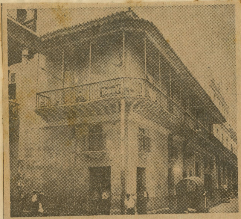
La vieja casa de Oficios número 76, esquina a Luz, nos muestra su típico balcón sostenido por dobles cabezas de vigas, sirviendo a la vez que de refuerzo, de motivo de ornamentación.
